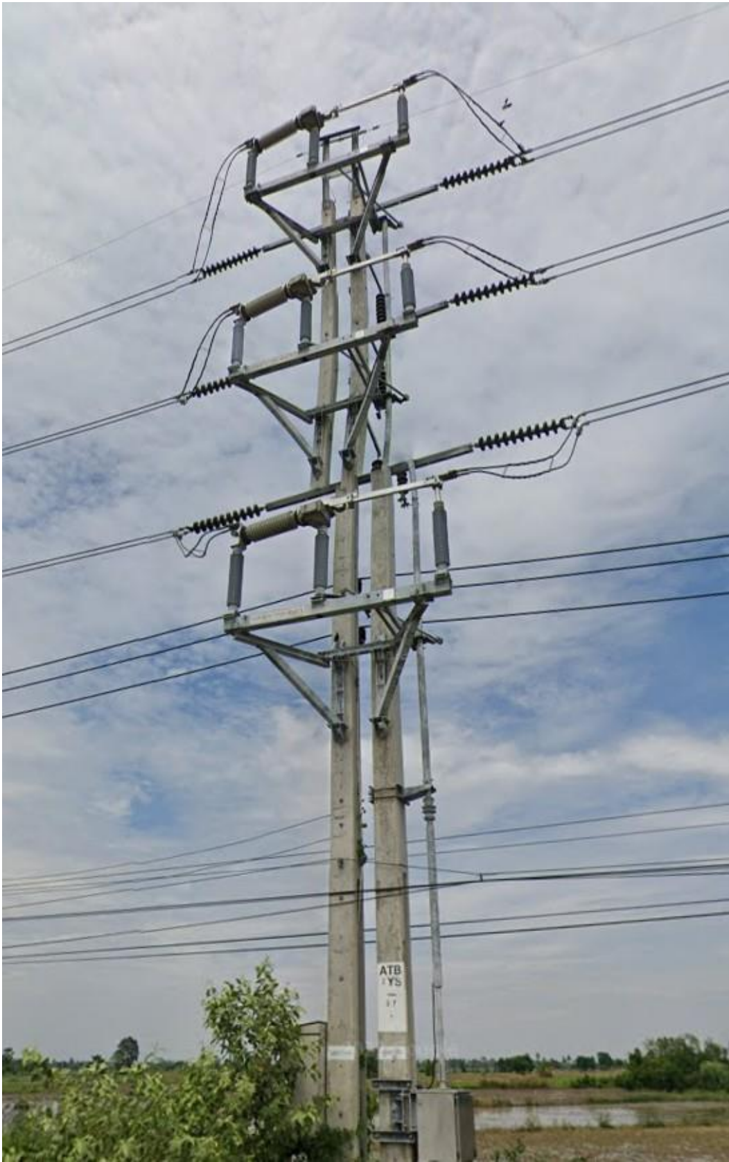
ปลด Load Break 115 kV รหัส ATB 2YS-07 (แยกวัดลาดปลาเค้า)
